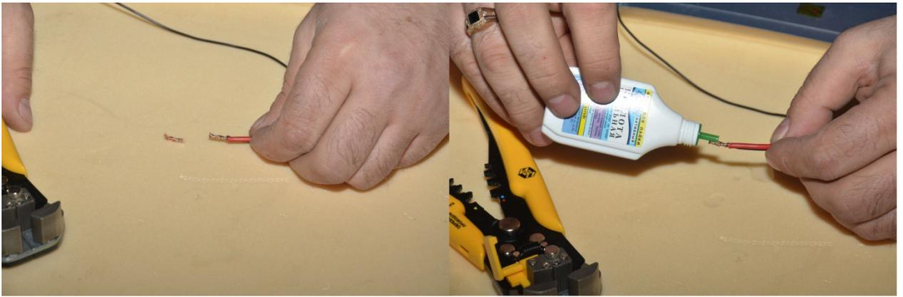
И паяем... В качестве изоляции используем термоусадочную трубку. Размер подбираем таким образом, чтобы изоляция превышала длину спая в два раза.
