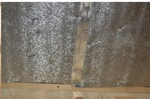
С помощью канцелярского ножа удаляем излишки скотча и отражающего материала.
